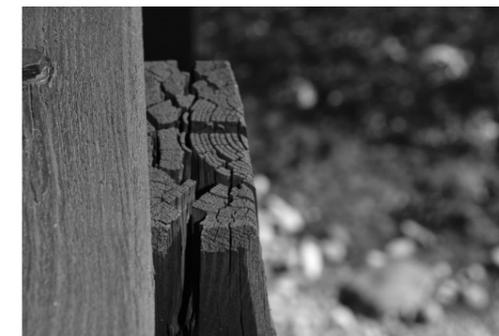
Biodegradamento per una sottovalutata progettazione della durabilità
