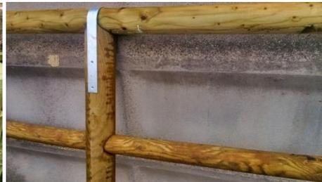
L'assenza di incastro in testata, impone di legare i pezzi con una fascia metallica, a sua volta fissata con chiodi o viti. Nel medio c'è compenetrazione, ma la sezione del traverso è minore di quella del montante e manca del tutto il rasamento.
