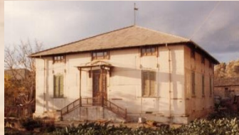
Ex casa di legno ed eternit - San Sperato, Reggio Calabria
